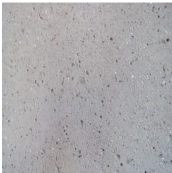
Ortbeton für Wege Innenhof
