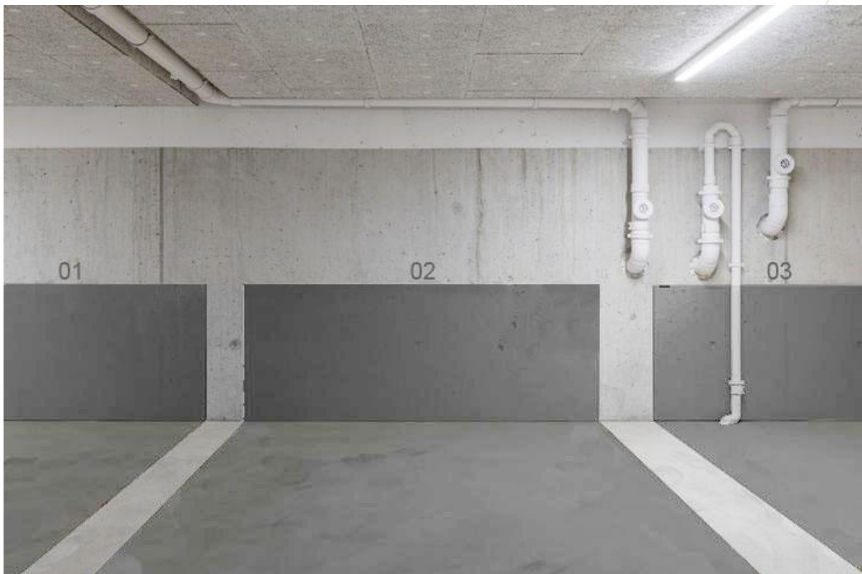
Boden mit Stellplatzmarkierung und Nummerierung
